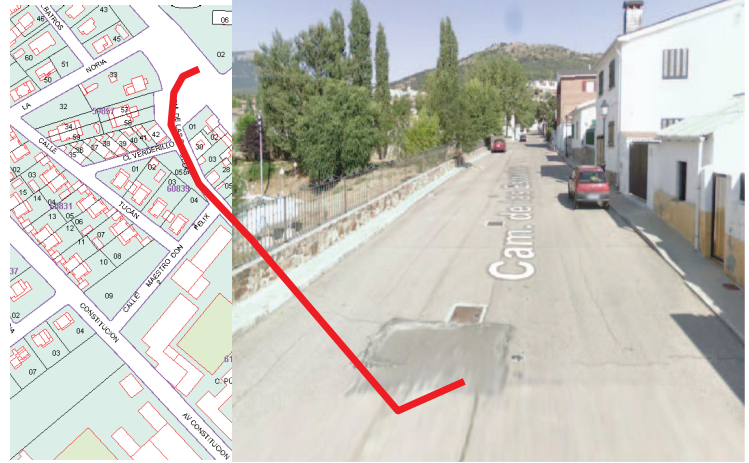
Calle Pastrana (superficie aproximada: 1.025 m 2 ):
